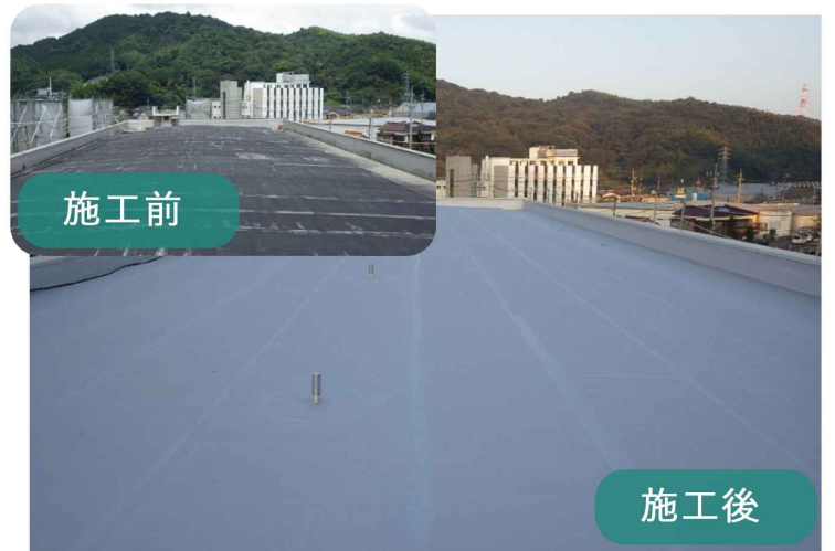
中学校校舎屋上
