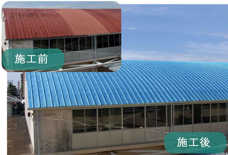
小学校体育館
